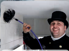
Reinigung einer Lüftungsanlage
