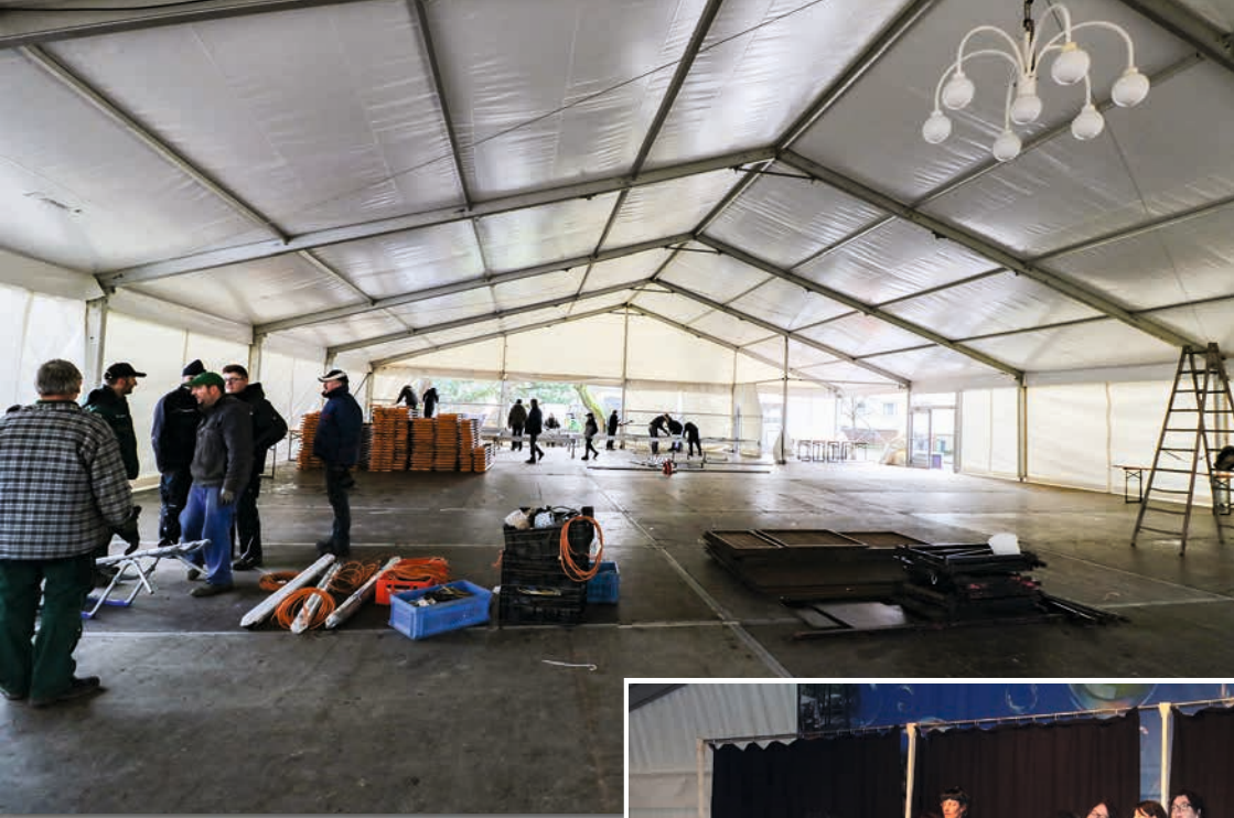
Das Zelt wird aufgebaut.
